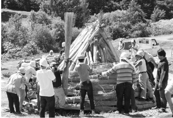
下地茅の設置と結束の様子
