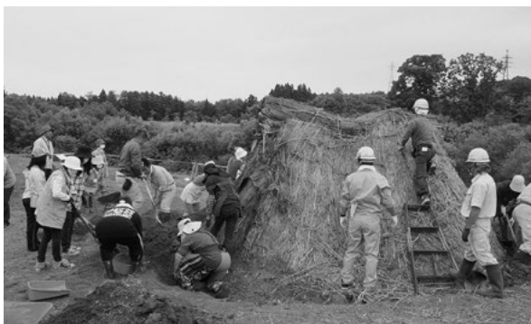
解体と除去の様子
