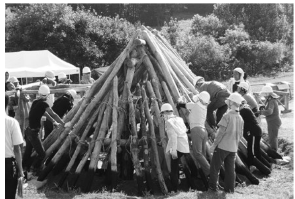
軸組組立の様子
