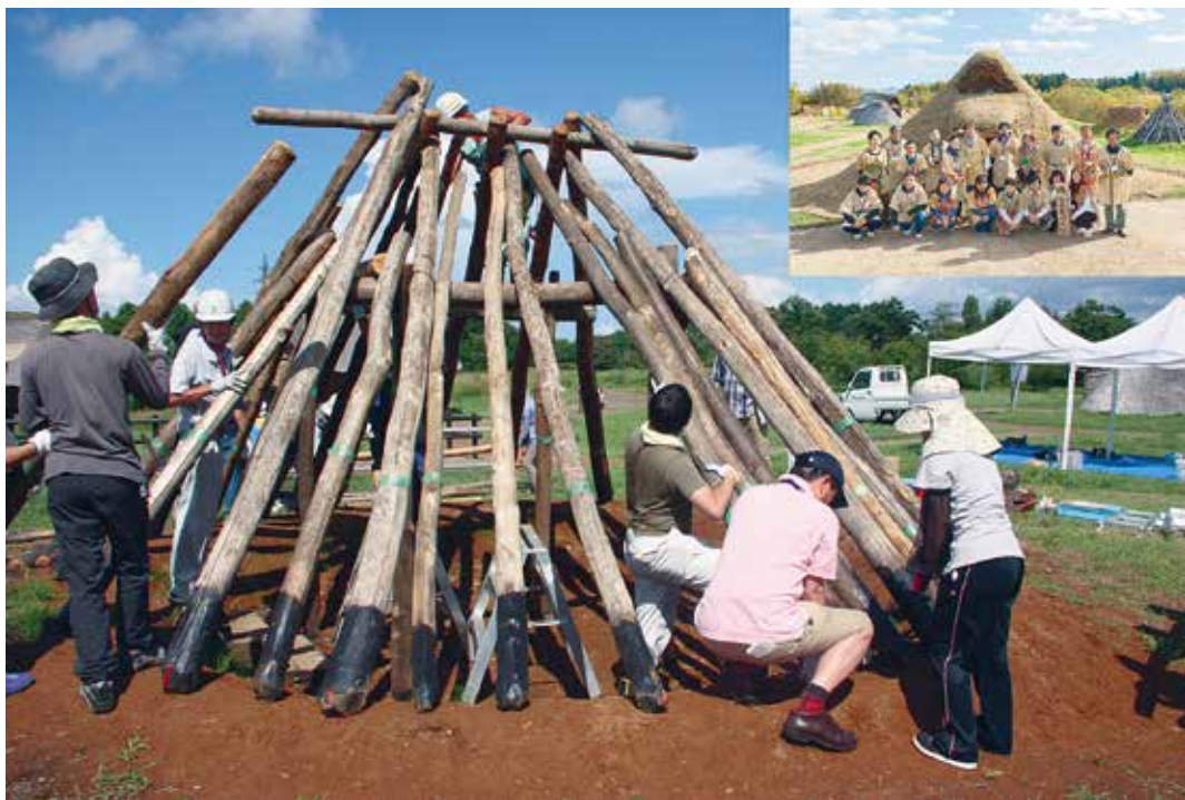
縄文の家づくり体験 軸組組み立ての様子 (右上は完成セレモニーの様子)
