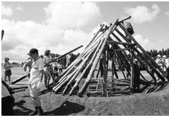
軸組組立の様子
