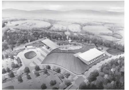
【完成イメージ 右側の白い建物が増築建物】
