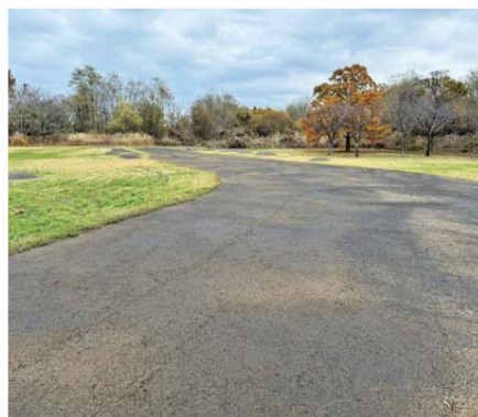
【改修工事を終えた園路】
