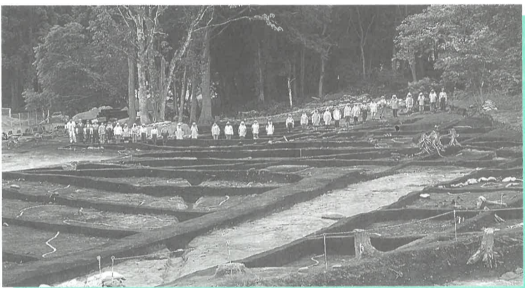
昨年検出された道路跡（中央のくぼんでいるところが道路跡）
