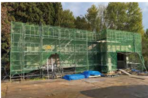
改修の進む子供の墓の覆屋
